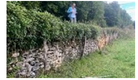
LA COMBE DES LOUPS SOUTÈNEMENT ROUTIER
